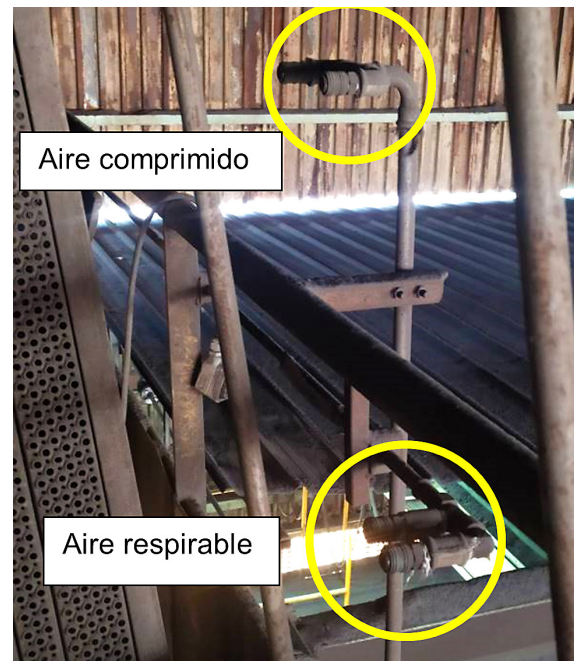
Figura 2: Puntos de conexión a la red de suministro de aire existentes en el nivel de tragantes
